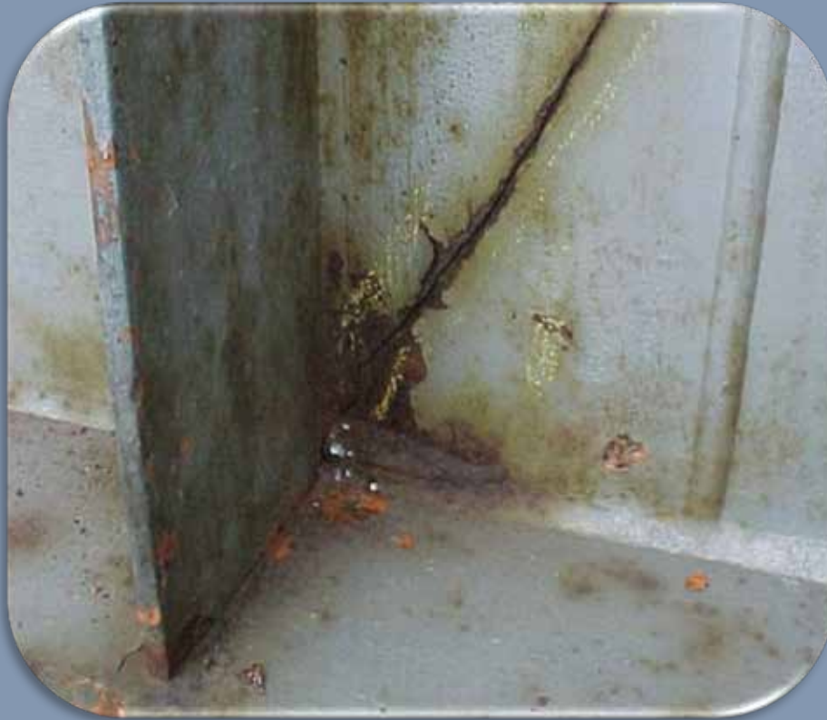
Fatigue Crack
